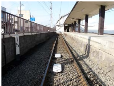
ATS地上子の新設
